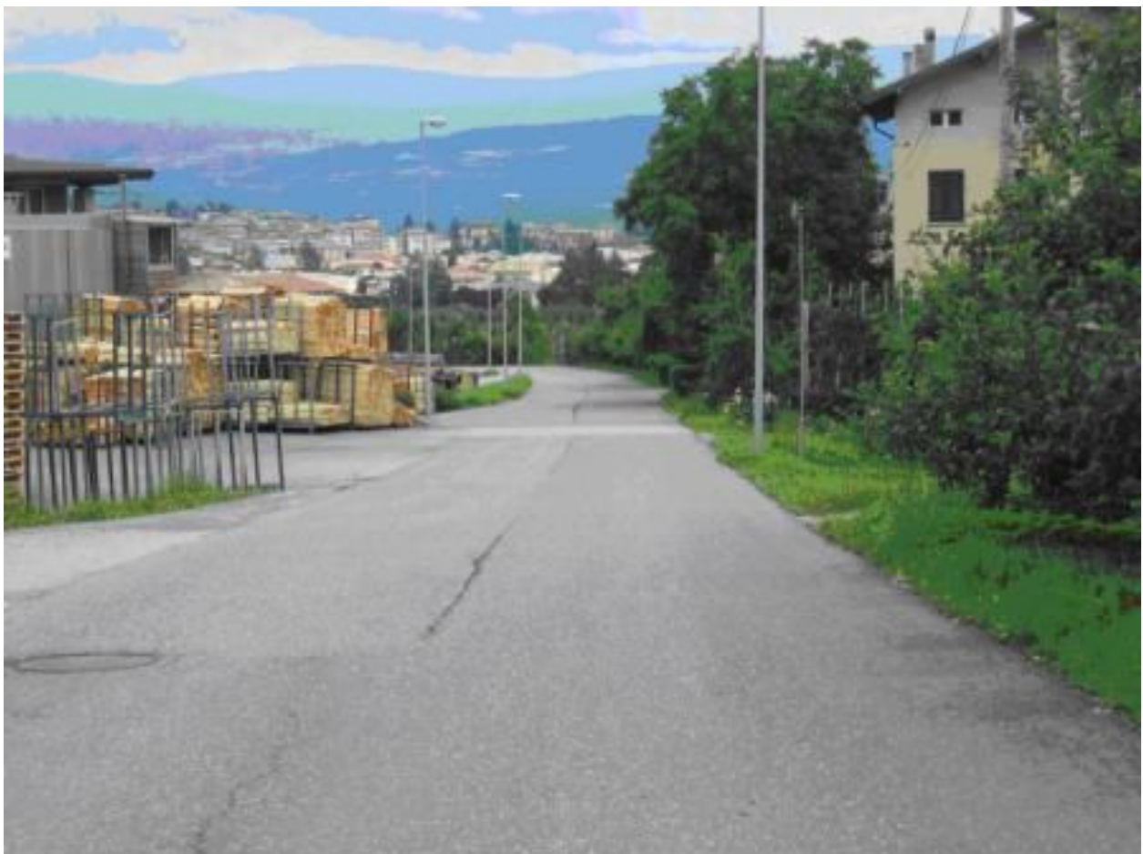
Rettilineo dove verrà posizionata la Vasca dell'acqua
